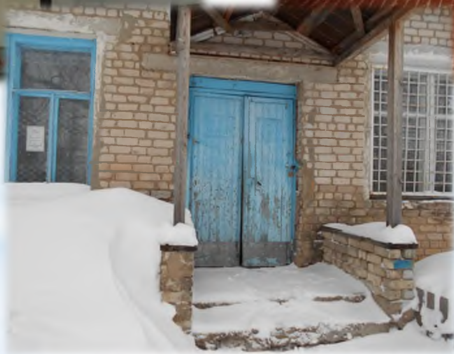
ремонт крыльца и установка пандуса
